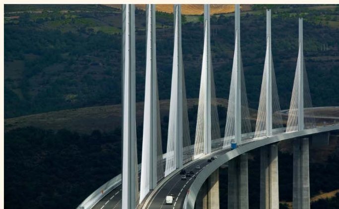
Het bekende viaduct van Millau in Frankrijk zit propvol sensortechnologie om de veiligheid te garanderen. © TARN VALLEY/BELGA
